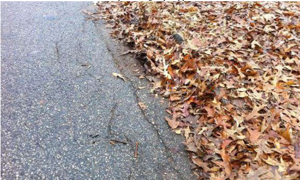
Fig. Edge Cracks
