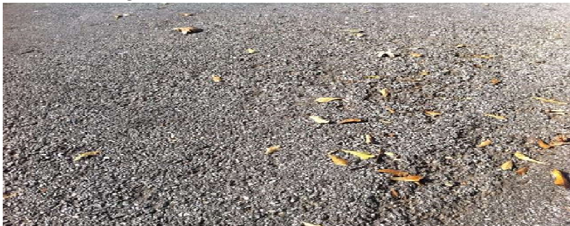
Fig. Raveling (very porous asphalt)
